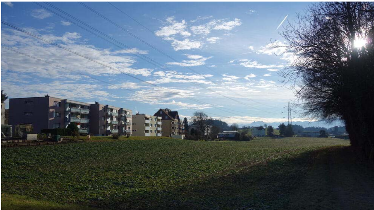
In der Grünenau beim Grüt wird der Anlagegrenzwert der Hochspannungsleitung stark überschritten. (Christian Brändli)
