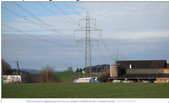
Die Hochspannungsleitung nach Grynau tangiert im Betzhof den Autobahnkreisel.
