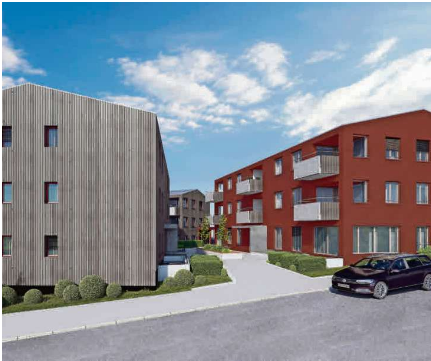
Das Haupthaus (rechts) und die zwei Nebengebäude: Statt des Restaurants Freieck im Grüt sind drei Neubauten geplant.
